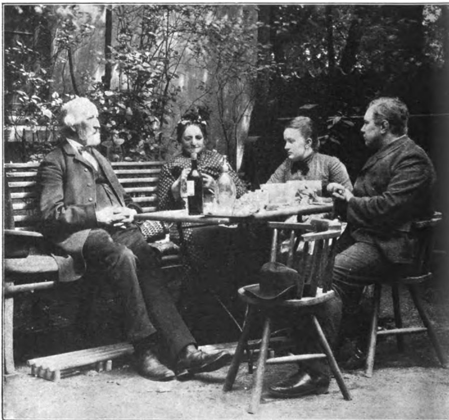
Groth und Allers im Hause Griefe in Hamburg. Phot. Carl Griefe.
